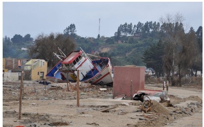
Figura 4. Efecto del tsunami en las calles del interior de Dichato (nótese el barco a gran distancia del mar).
