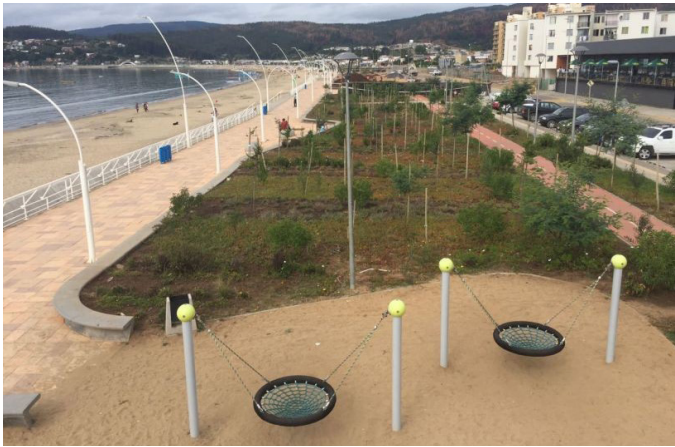
Figura 7. Tramo terminado de las obras de la Costanera y área de mitigación de Dichato.
